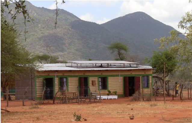
Fig. 2. Ikisaya Energy Center.
